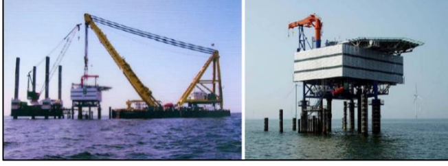
Şekil 5.33. Horns Rev DRES şalt sahası montajı.
