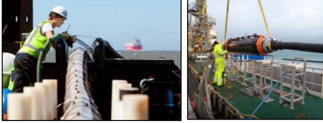
Şekil 5.34. Horns Rev DRES denizaltı kablo serilmesi.
