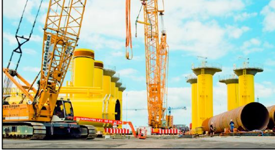
Şekil 9.3. Limanda tek kazıklı temel depolanması.
