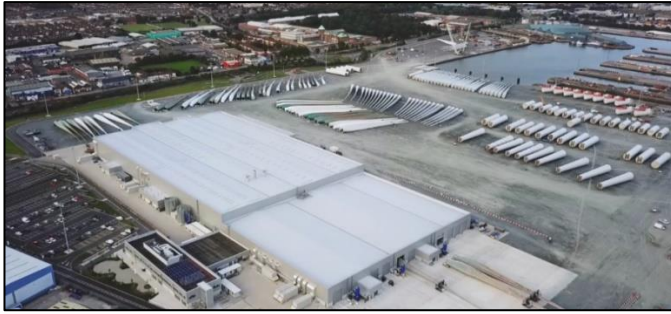
Şekil 9.1. Siemens Hull Limanı kanat fabrikası.
