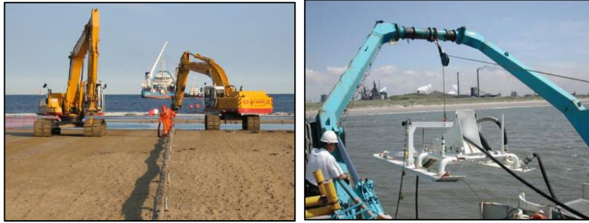
Şekil 5.9. Denizaltı kablo montajı.
