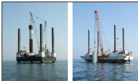
Şekil 5.32. Horns Rev DRES türbin montajı.
