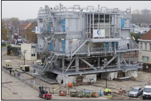
Şekil 8.8. DRES şalt sahası limanda görünümü.
