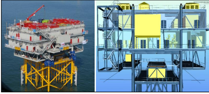
Şekil 5.18. Thornton Bank DRES denizüstü şalt sahası.
