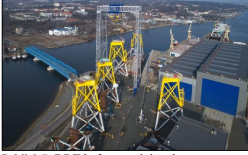
Şekil 8.7. DRT kafes temel depolanması.
