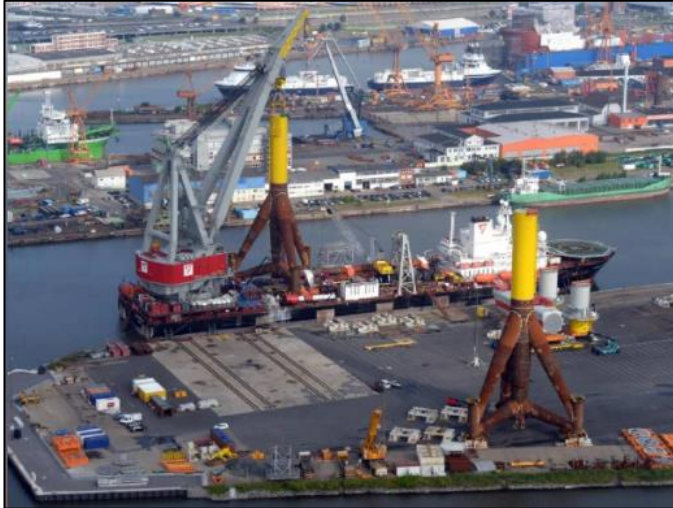
Şekil 8.20. Bremerhaven limanı grup kazıklı temel.
