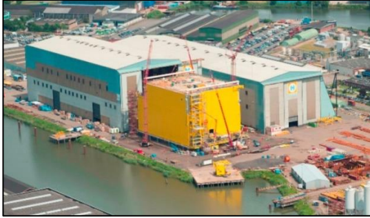
Şekil 9.6. Hollanda Zwijndrecht limanında bulunan denizüstü şalt sahası üretim tesisi.
