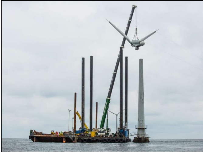
Şekil 10.1. Vindeby denizüstü rüzgar türbin demontajı.
