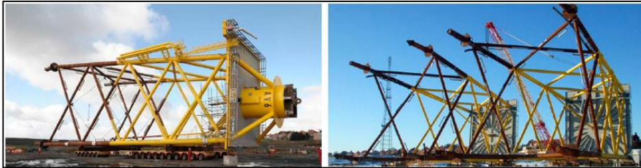
Şekil 9.4. Limandaki rıhtımda kafes temel depolanması.
